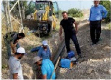
İLÇENİN TÜM Altyapı sorunlarına kalıcı çözüm
